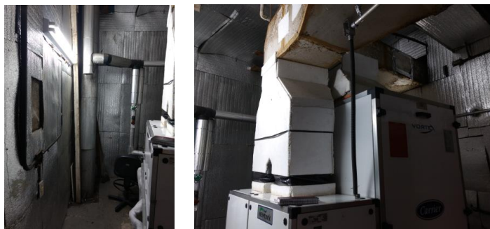
Fancoils a serem removidos do local de instalação atual para a CAG do subsolo do Anexo II
