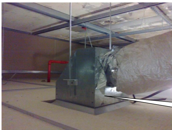
Foto 1 - Instalação típica de difusor
